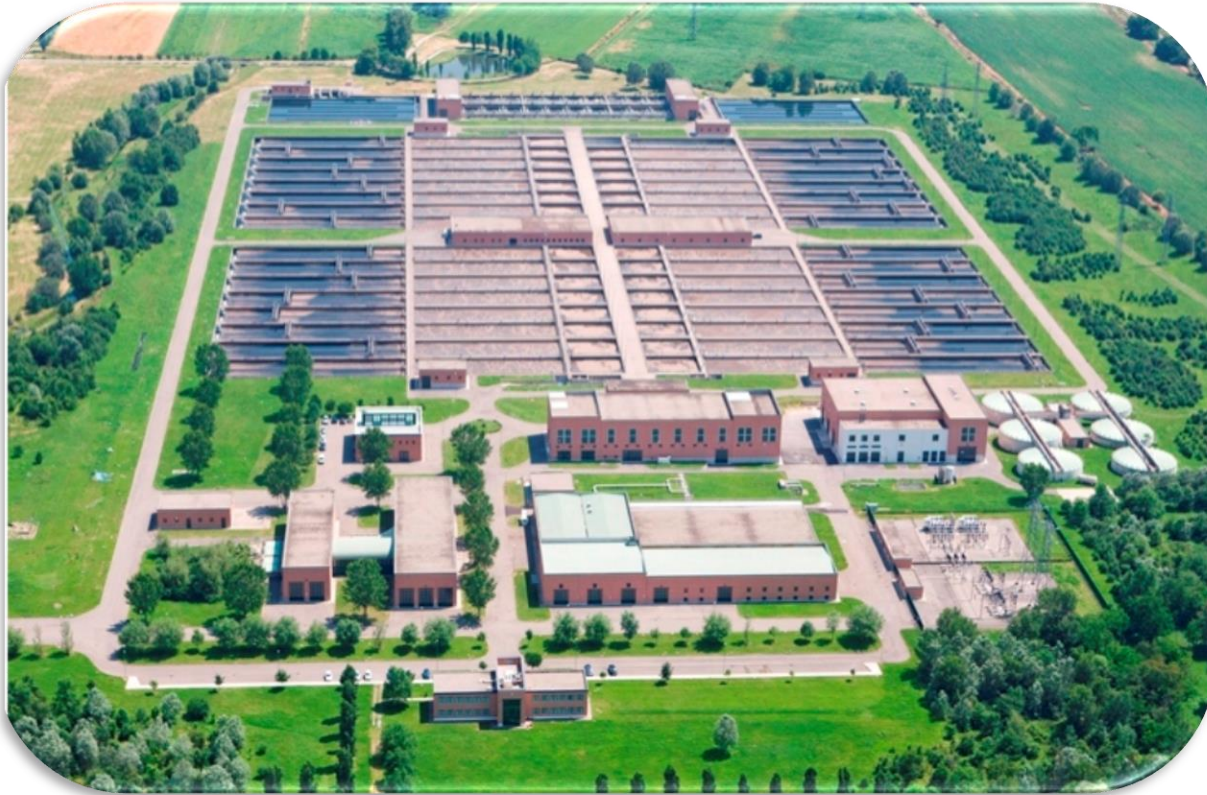
WWTP MILANO NOSEDO
