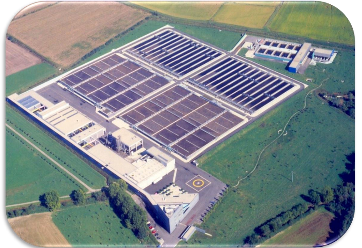
WWTP MILANO SAN ROCCO
