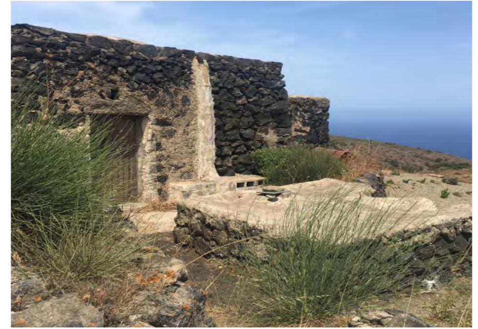
L'unicità del paesaggio rurale storico di Pantelleria è strettamente connessa ad una specifica tipologia costruttiva, quella del **ddammusu**, un volume elementare, generalmente a base quadrata o rettangolare, realizzato con muri in pietra a secco e coperto da una volta.
